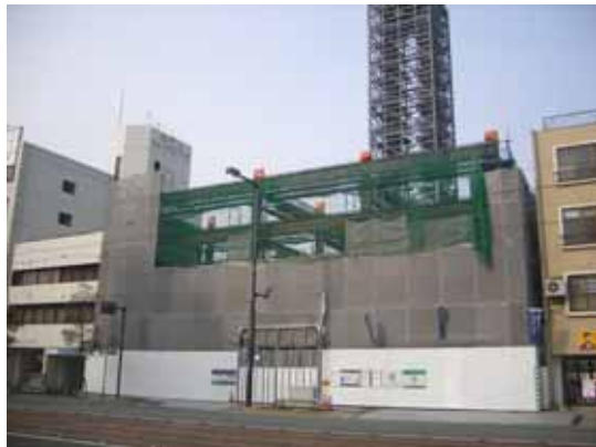
5階迄の鉄骨建て方。奥に見えるのが立体駐車場。
