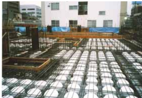
床スラブ配筋工事
